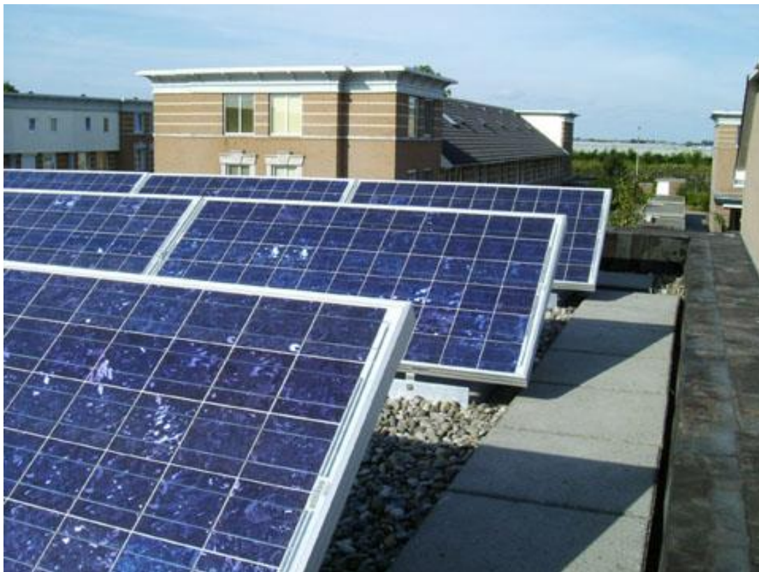
Voorbeeld: PV-systeem in een plattendak opstelling
